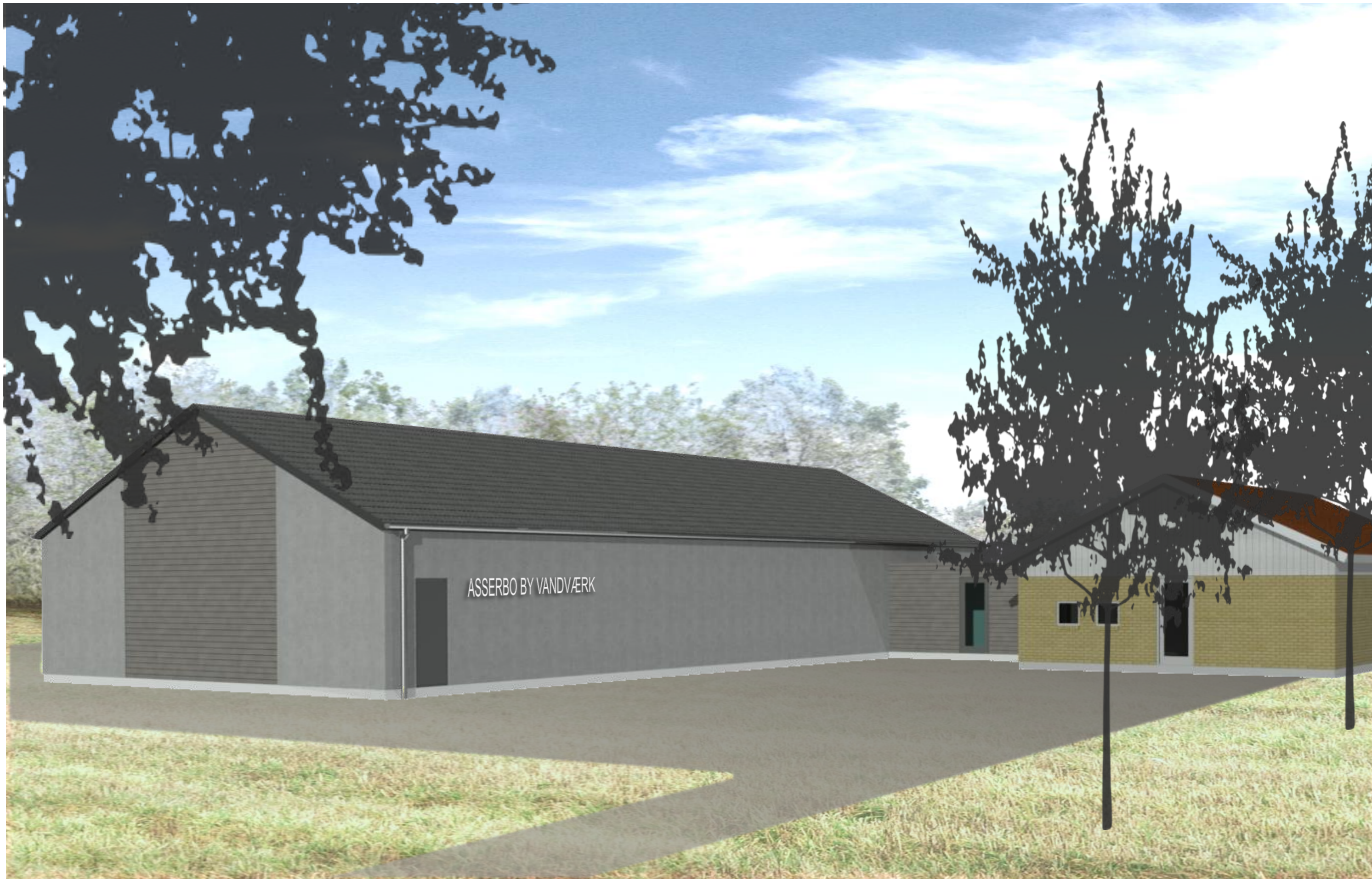
ASSERBO BY VANDVÆRK Nyt vandværk April 2020
